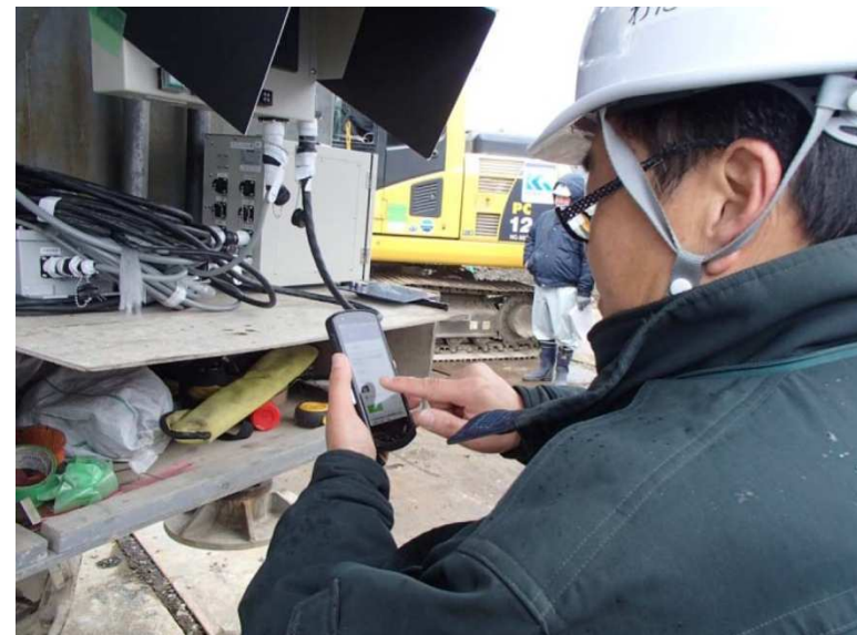
スマートフォンを活用した施工管理
