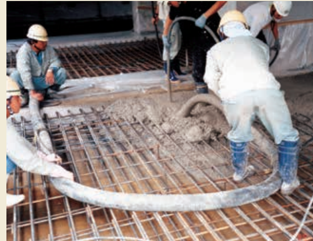
5 底板部コンクリート打設
