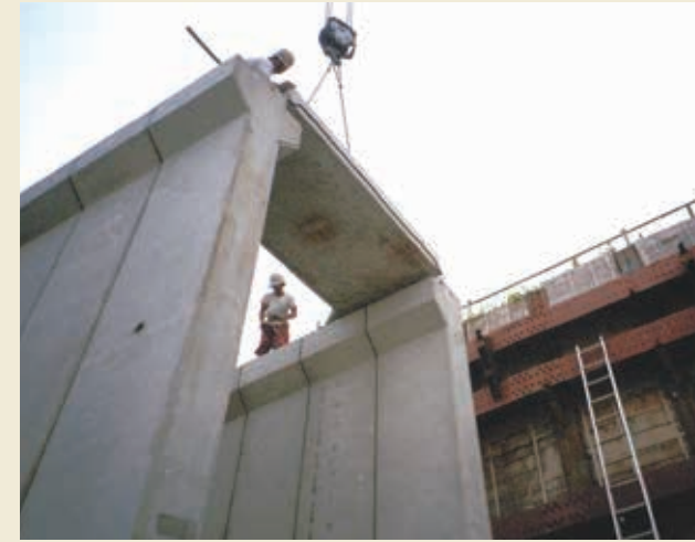
2 スラブの据付
