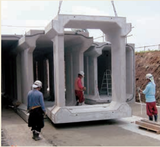
1 ボックス型タイプ ブロックの据付
