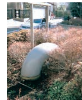
●地上部 換気孔
