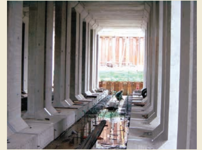
3 プレキャストブロックの据付完了
