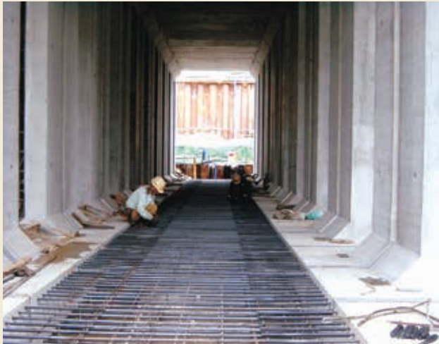
4 底板現場打ち部の配筋
