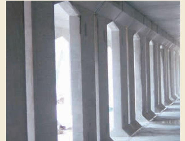
7 完成した遊水池の内部
