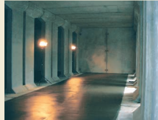
6 コンクリート打設完了
