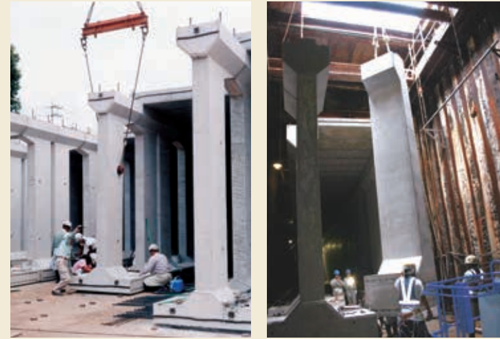
スタンド型タイプ ブロックの据付
