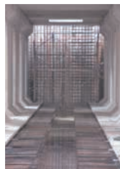
●現場打ち端壁
