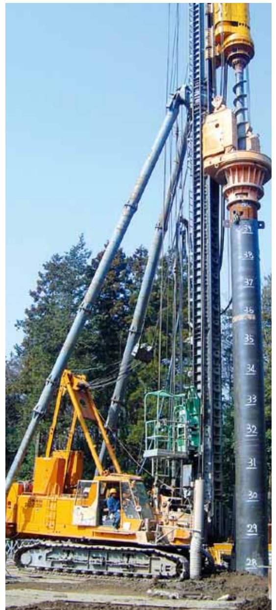
■施工状況(同時埋設方式)
