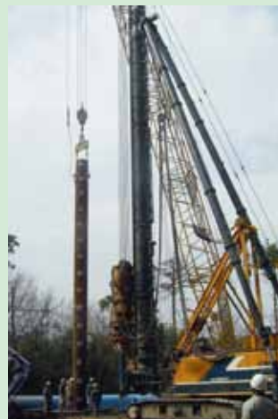
クレーンによる鋼管建込み
