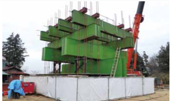
鉛直載荷試験
