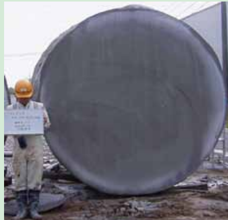
根固め球根の切断状況 品質のバラツキがないことを確認
