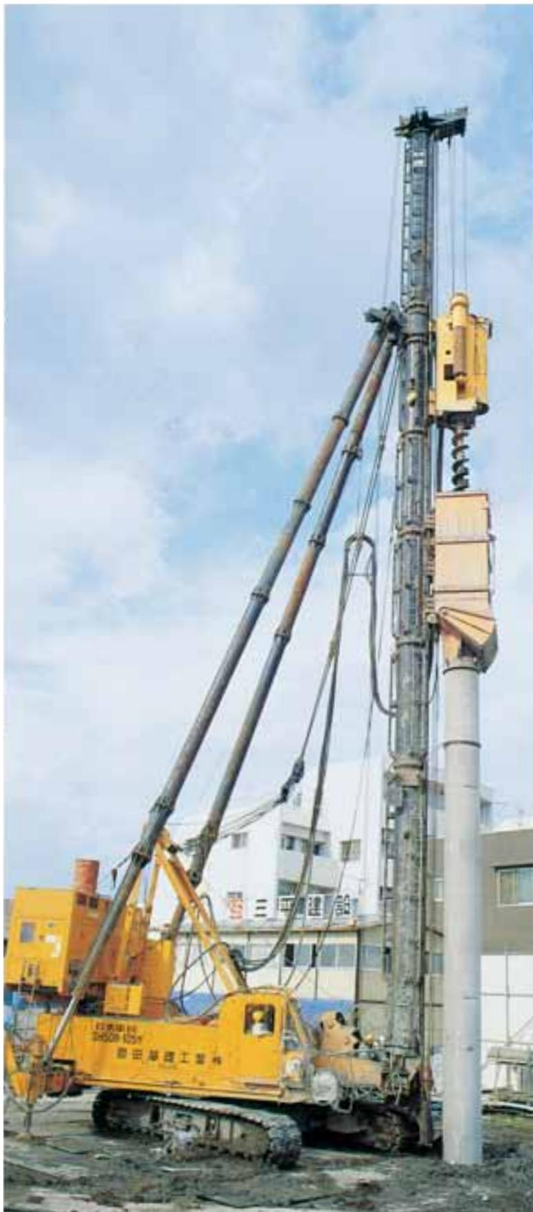
STJ工法は、先端部に高圧噴射ノズルをもつ、STJビットを取付けた連続スパイラルオーガを、あらかじめ杭中空部に挿入して杭を建込み、オーガ駆動装置にスパイラルオーガを連結し、掘削を開始します。杭先端が支持層の所定深さに達した後、拡大球根の築造を行います。STJビットの2方向ノズルより高圧水を噴射し支持層の掘削を行った後、オーガの回転を低速に切換え、根固め液（セメントミルク）を圧力18MPa以上でSTJビットから2方向へ高圧噴射させながら、ゆっくりスパイラルオーガを引き上げ拡大球根を築造します。引続き杭中空部内にもジェット噴射しながら、所定の高さまでスパイラルオーガを引き上げて、杭先端部の球根築造の作業を完了します。その後、杭中空部内に注水しながらスパイラルオーガを引き抜き施工を完了します。杭先端部に高圧噴射された根固め液の硬化によって、杭体と球根を一体化させ、杭の支持力を発現させる工法であります。
