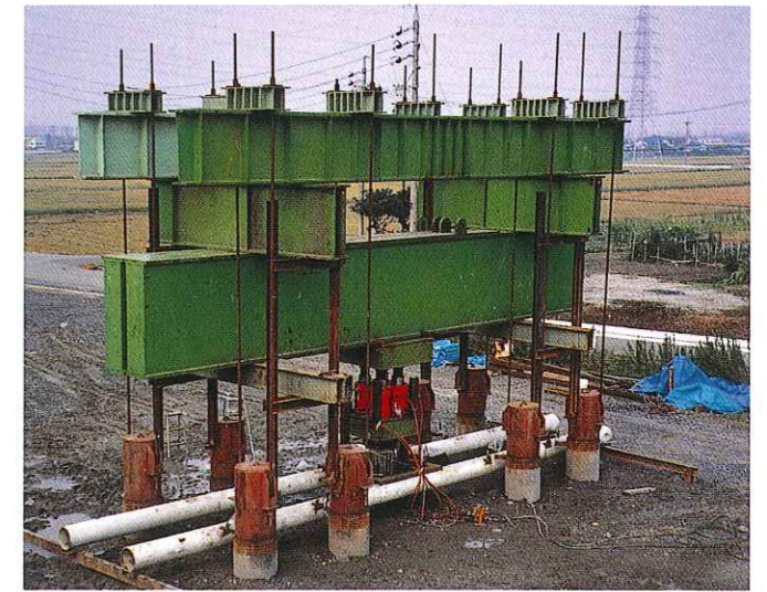
【載荷試験装置】
