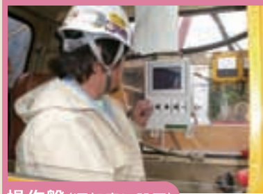
操作盤 (運転席に設置)
