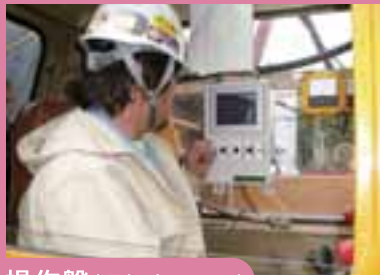
操作盤 (運転席に設置)
