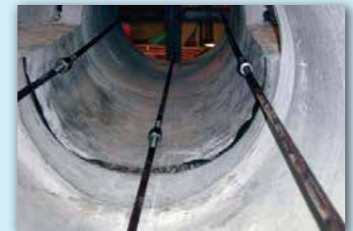
▲管の40mm突出し時の吸収ゴムブロックの確認 (ゴムの潰れによる衝撃の吸収緩和)
