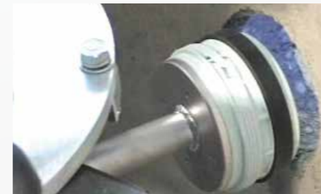
▲消散弁の圧入状況
