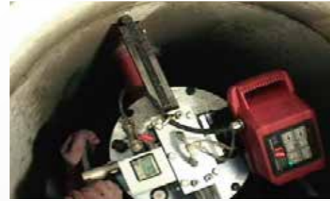
▲マンホール壁の削孔状況
