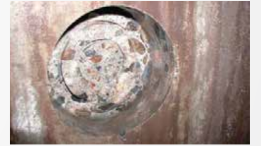
▲削孔完了状況
