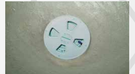
▲施工完了状況
