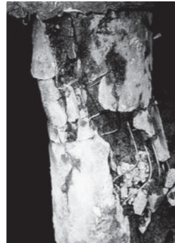
杭頭を剛接した杭の被害例
