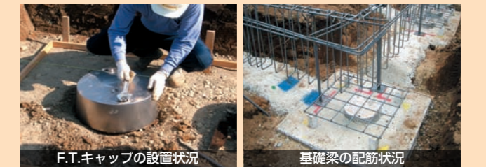
F.T.キャップの設置状況
