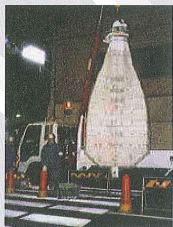
狭いスペースでも楽に施工
