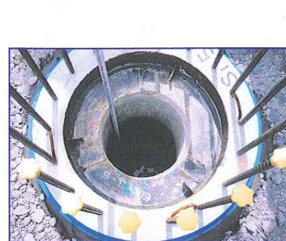
① 中詰深さを検尺にて測定
