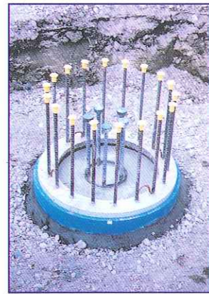
⑧ 中詰コンクリートを所定のレベルまで打設
