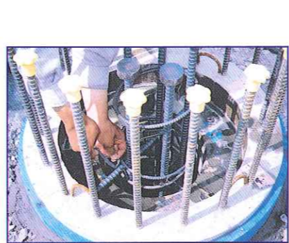
⑥ 鉄筋カゴはかざし筋にて支持
