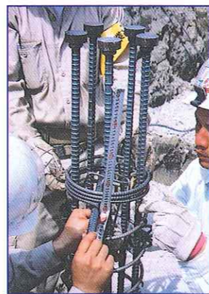
④ 鉄筋カゴの組立て
