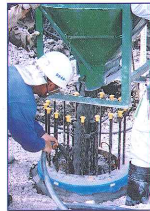
⑦ 中詰コンクリート打設
