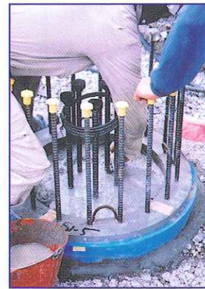
⑧ 中詰コンクリートを所定のレベルまで打設
