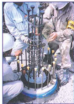
⑤ 鉄筋カゴのセット
