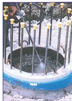
② 杭内面の洗浄
