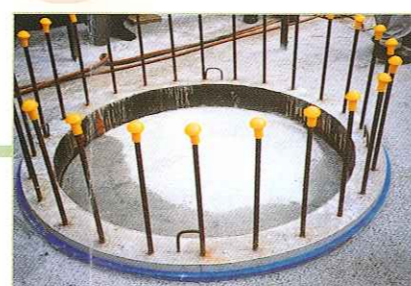
杭頭処理完了
