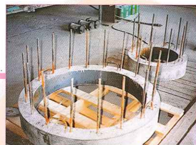
型枠脱型後
