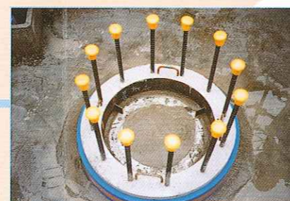
PCリング設置完了
