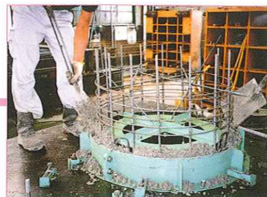
コンクリート打設状況
