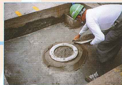
杭頭にモルタルを敷く
