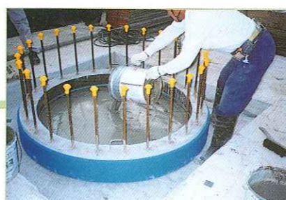
杭頭モルタル打設
